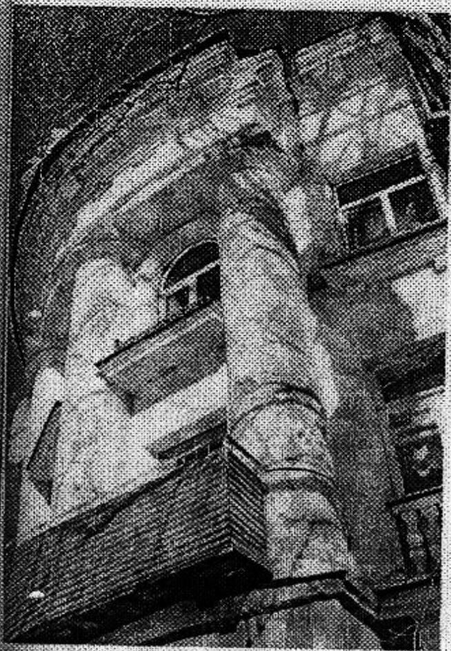
Фото № 15. Фрагмент главного фасада.
