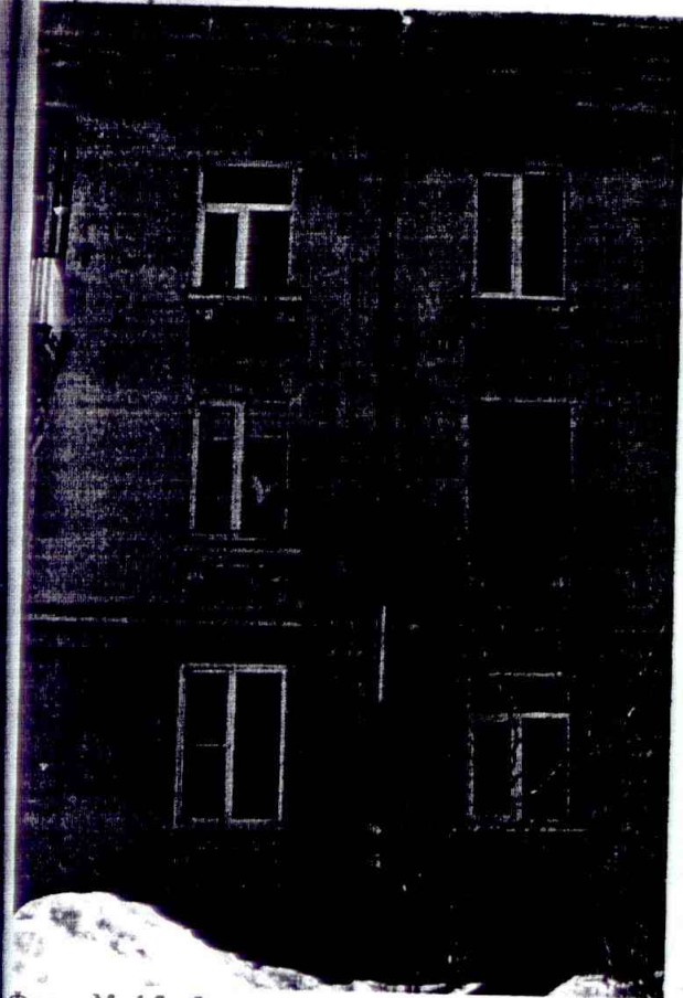
Фото № 15. Фрагмент дворового фасада .
