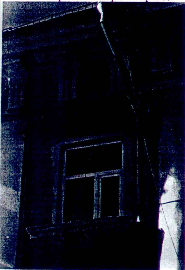
Фото № 19. Фрагмент главного фасада по ул. Крылова.
