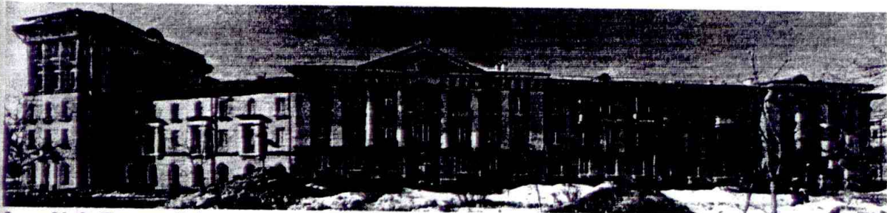
Фото № 2. Главный фасад по ул. Крылова.
