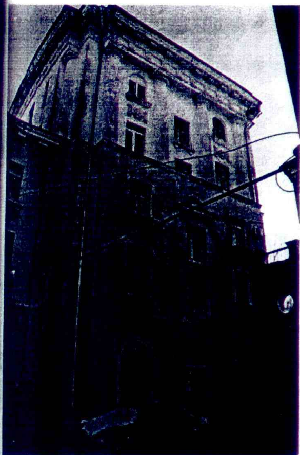
Фото № 9. Фрагмент дворового фасада.
