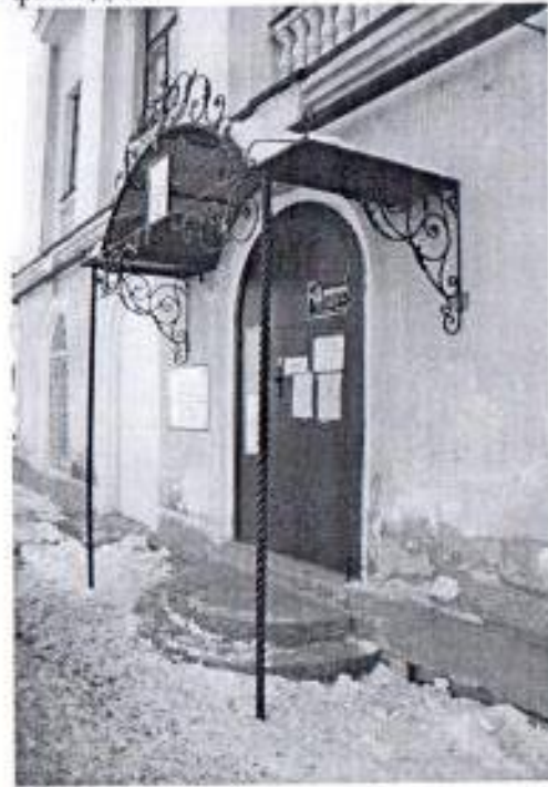
Фото № 38. Фрагмент главного фасада по ул. Никонова.
