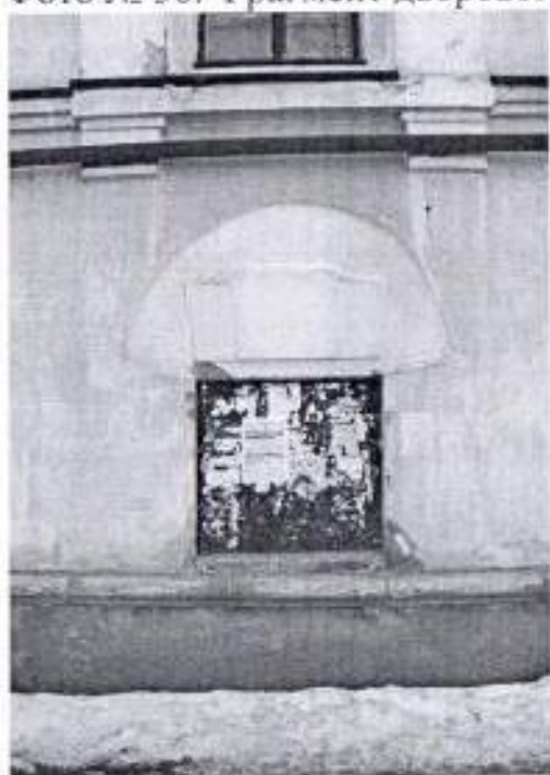
Фото № 37. Фрагмент главного фасада по ул. Никонова.
