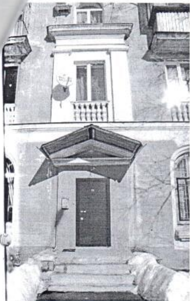
Фото № 9. Фрагмент главного фасада.
