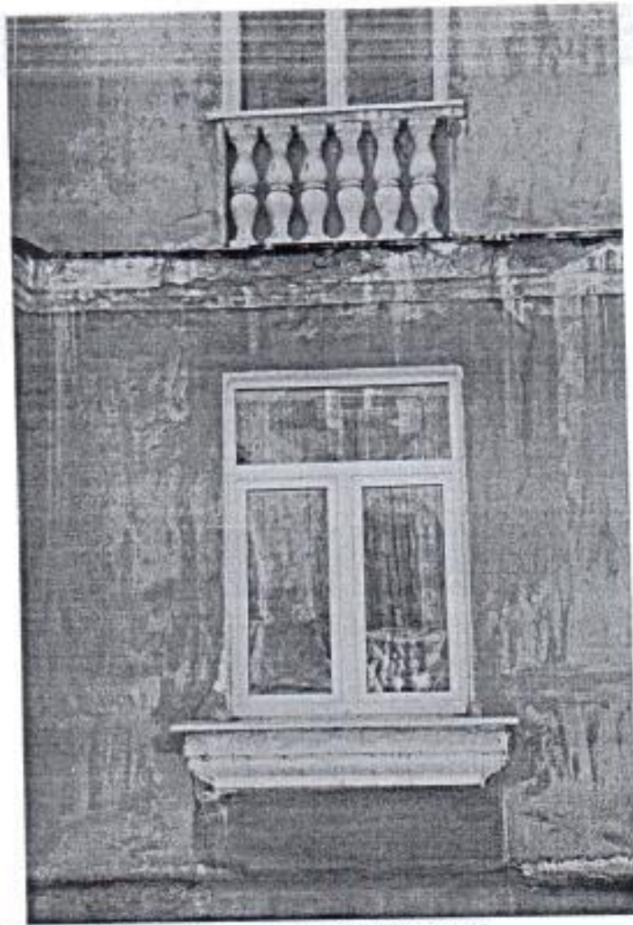
Фото № 15. Фрагмент С-3 фасада.
