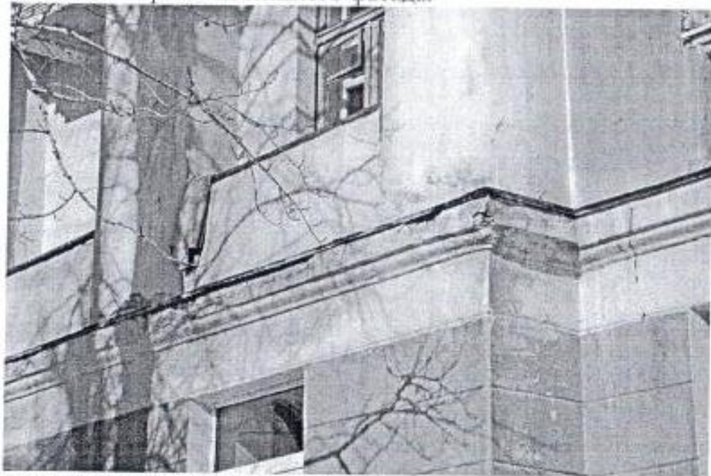
Фото № 7. Фрагмент главного фасада.
