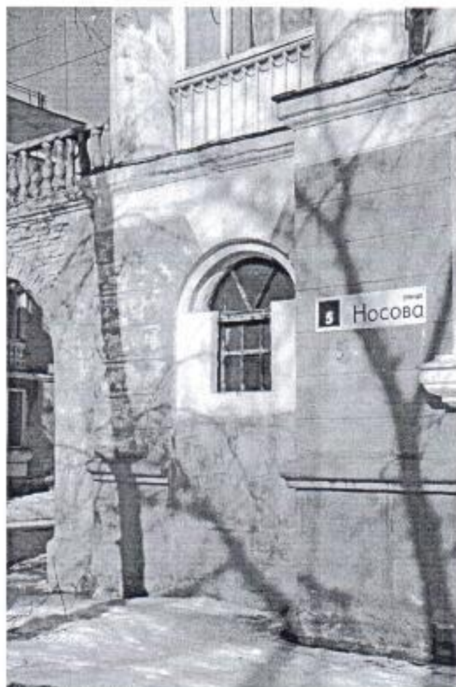
Фото № 10. Фрагмент главного фасада.
