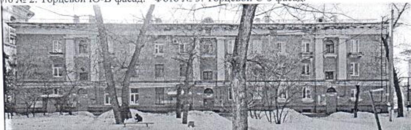
Фото № 4. Дворовой фасад.
