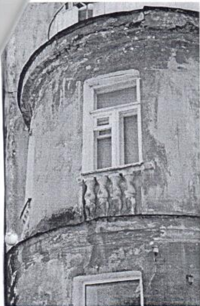
Фото № 16. Фрагмент С-З фасада.
