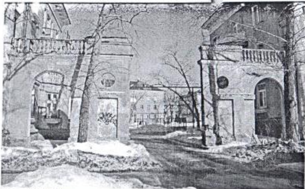
Фото № 5. Фрагмент главного фасада.
