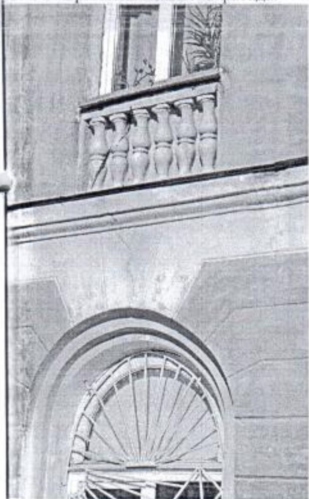
Фото № 11. Фрагмент главного фасада.
