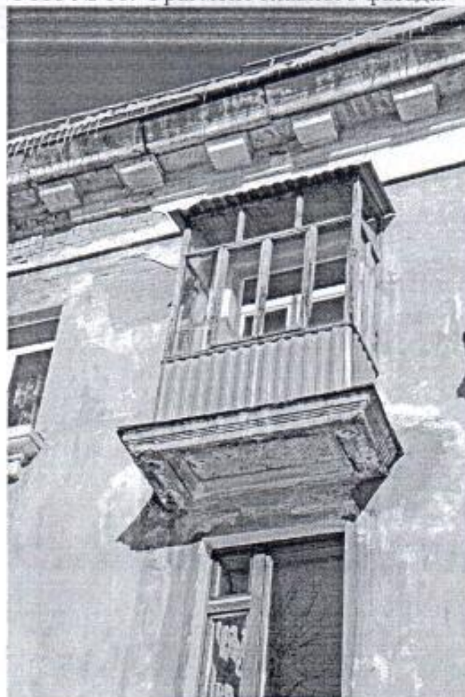
Фото № 12. Фрагмент главного фасада.
