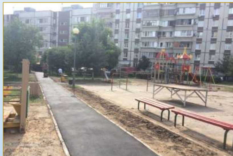
Фото объекта «В работе»
