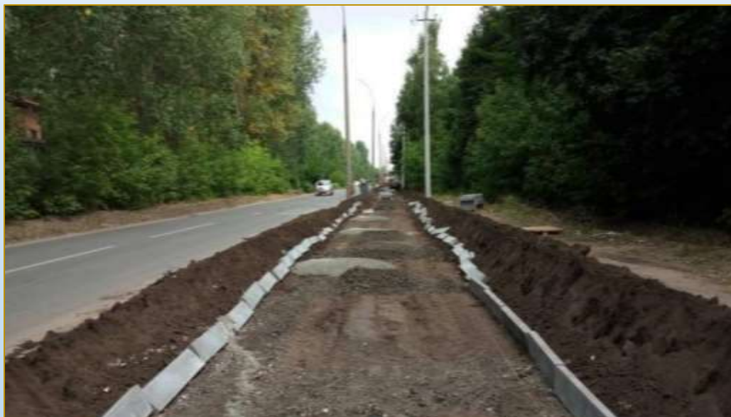
Фото объекта «В работе»
