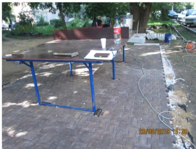
Фото объекта «В работе»
