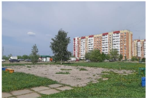
Фото объекта «До»
