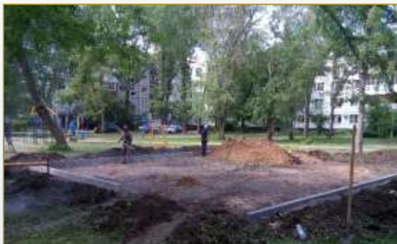
Фото объекта «В работе»
