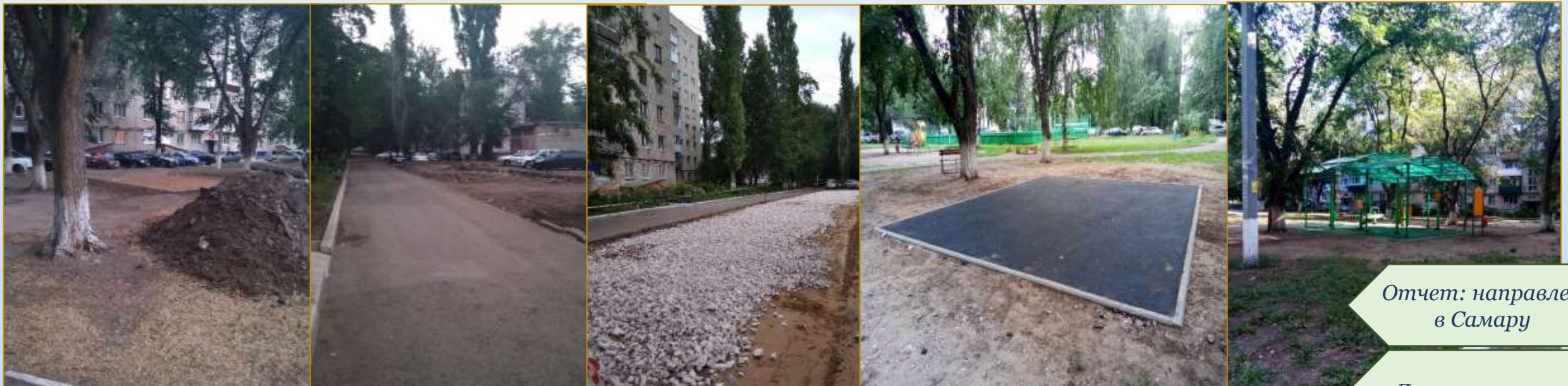
Фото объекта «В работе»
