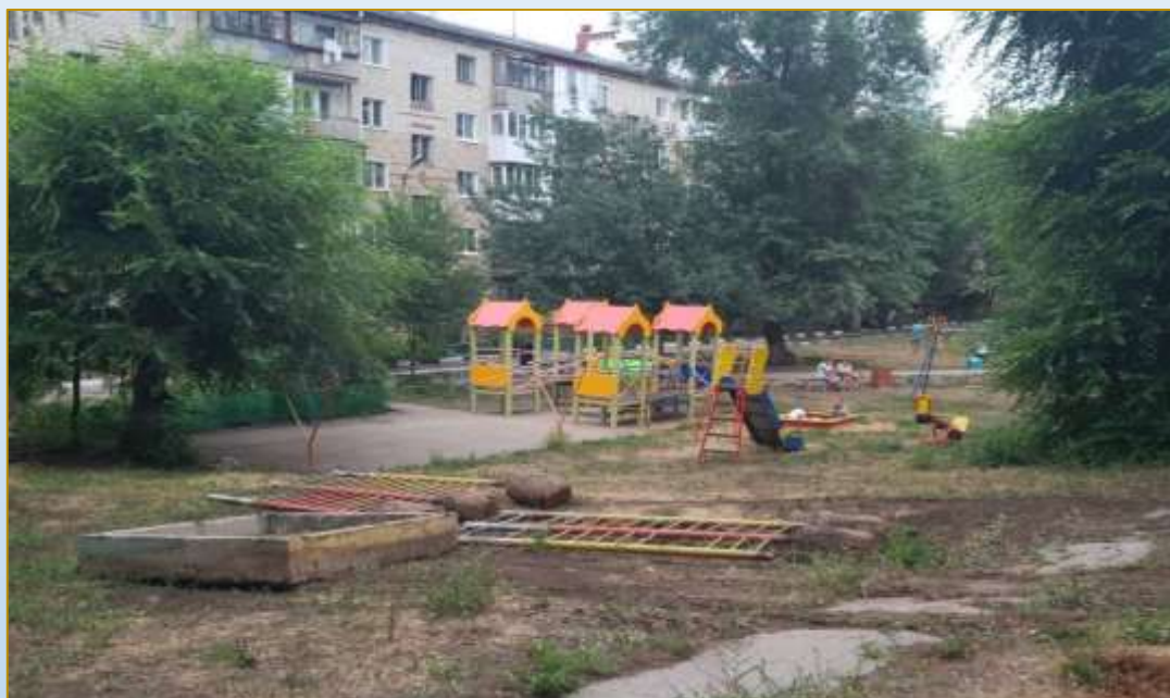
Фото объекта «В работе»
