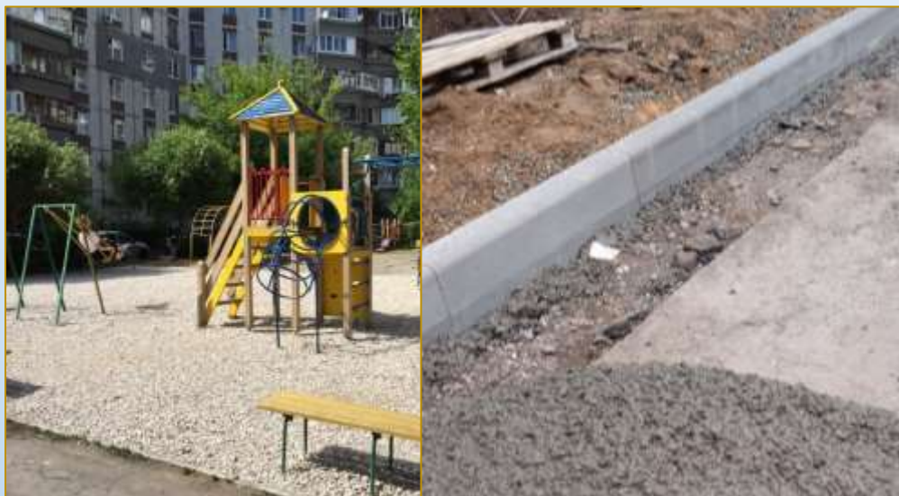
Фото объекта «В работе»
