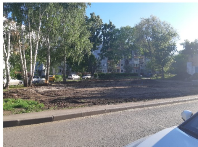
Фото объекта «В работе»
