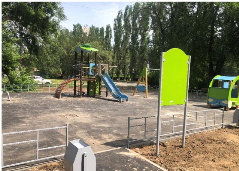
Фото объекта «В работе»
